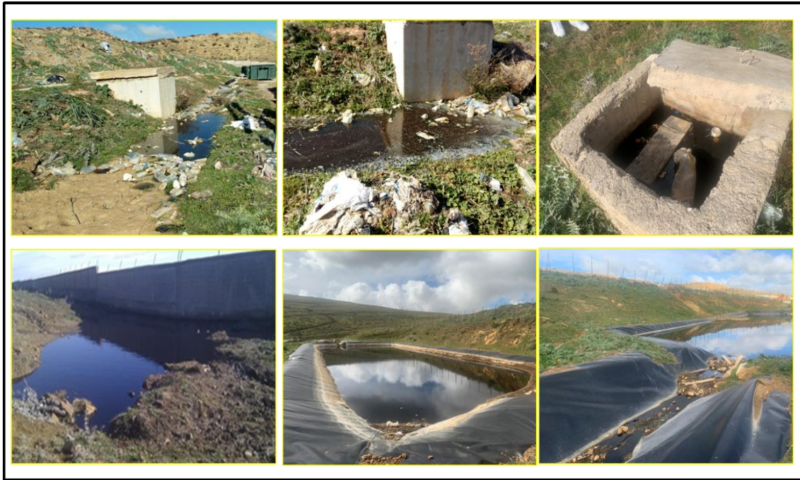
Figure n°07.27 : problèmes de gestion des lixiviats aux CET de Boughareb.
