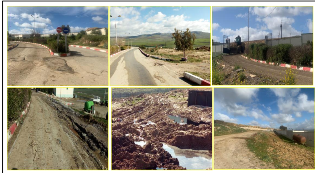
Figure n°07.12 : Etat général des voies de circulation interne au CET de « Boughareb »
