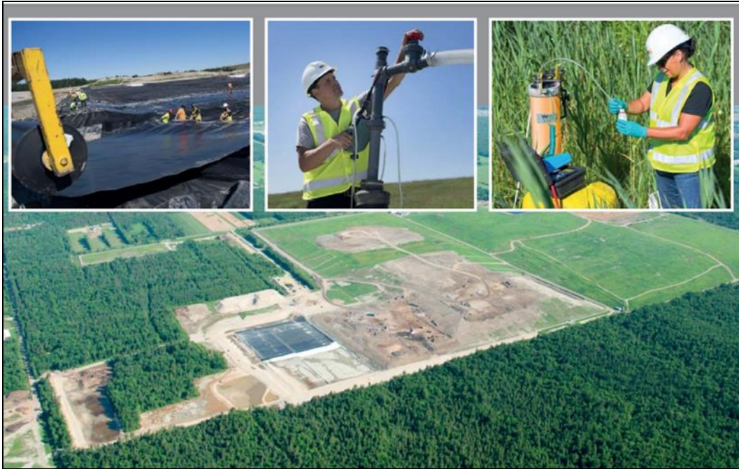
Figure n°04.06: Le lieu d'enfouissement technique (LET) de Sainte-Sophie, Canada.
