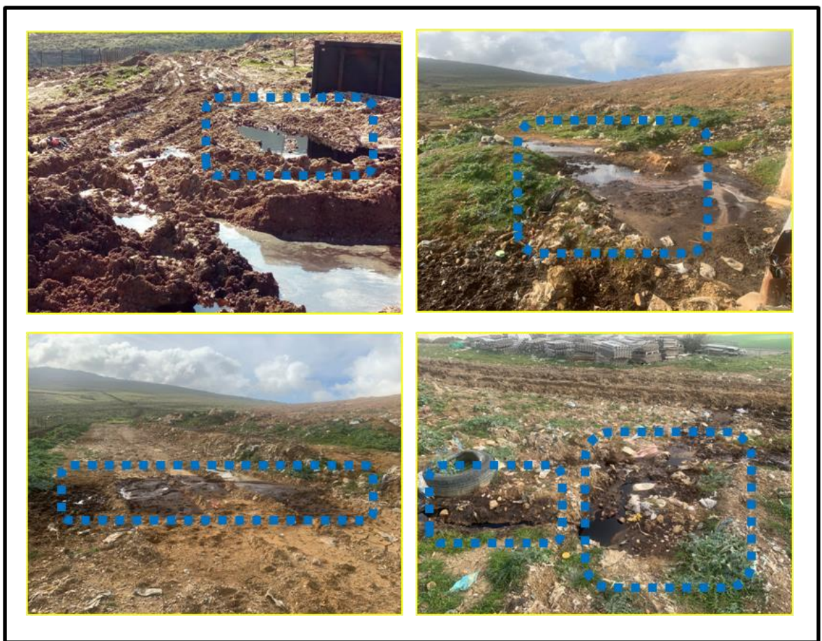
Figure n°07.16 : La présence des lixiviats en bas du casier fermé
