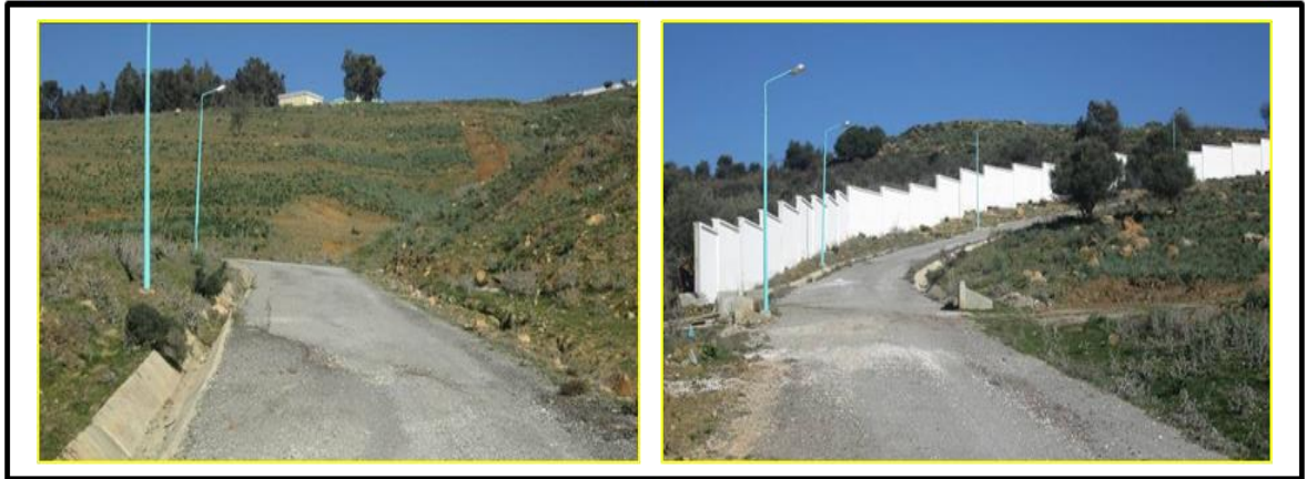
Figure n°07.06 : La voie d'accès au CET de Doghra
