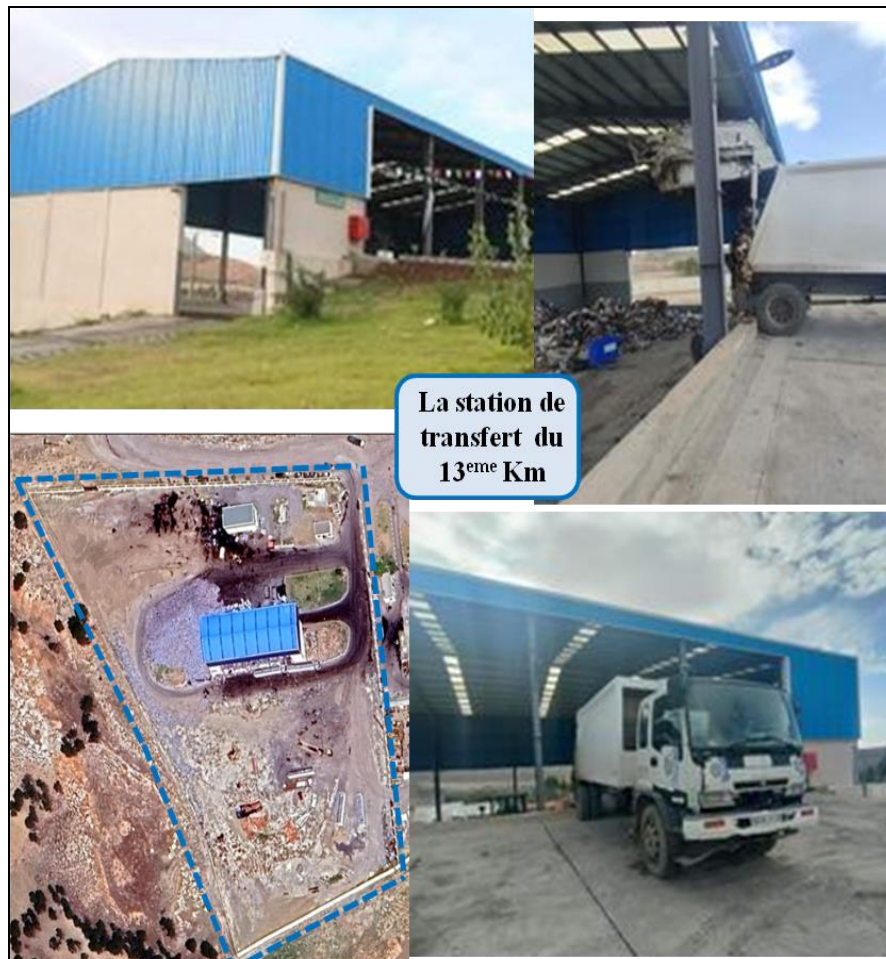
Figure n°06.15 : La station de transfert des DMA à Ain Smara. Constantine
