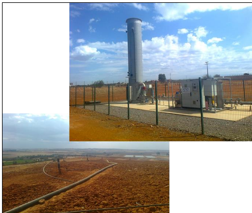
Figure n°04.11: Plateforme du projet de valorisation des déchets verts
