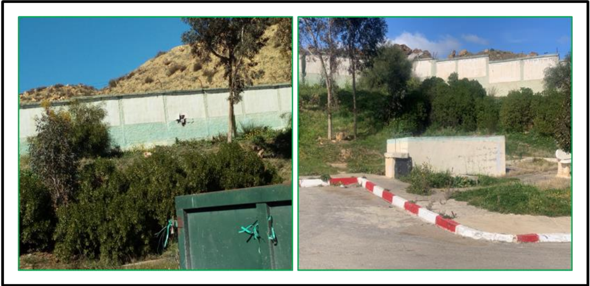
Figure n°07.19 : Ecran végétal discontinu pour embellir l'entrée du CET Source : Auteure. 2018, 2020
