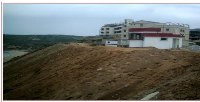
Photo n° 21 : Ben Mhidi Des constructions de la Direction de l'Environnement (en infraction de la loi littorale !)
