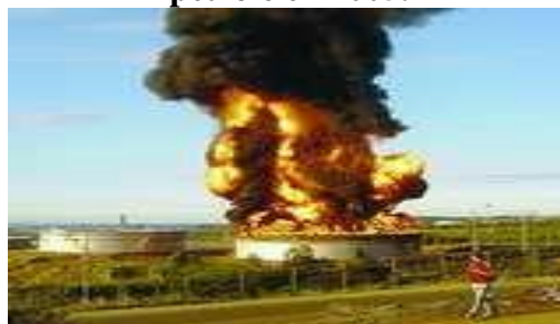
Photo n° 62 : Explosion d'un bac à pétrole en 2005.
