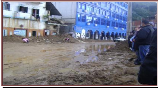
Photo n° 53 : Effondrement de bâtisse due à la crue à Stora
