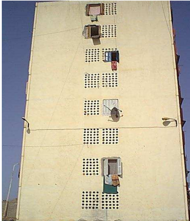
Photo n°30a : Façade modifiée système tunnel
