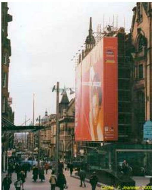
Photo n°7. Travaux d'embellissement, restauration et nettoyage de tous les polluants sur les façades et les toitures
