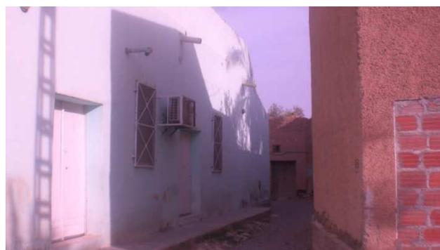
**Figure 3.39** : Façades enduites en mortier de ciment
