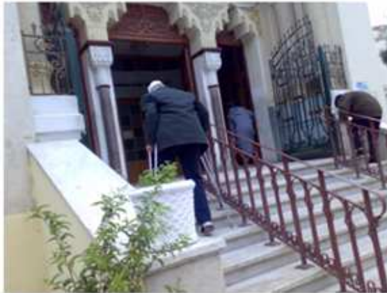
Figure n° 249 la prise en compte des personnes à mobilité réduite et des personnes âgées est inexistante dans nos aménagements. Source : auteur
