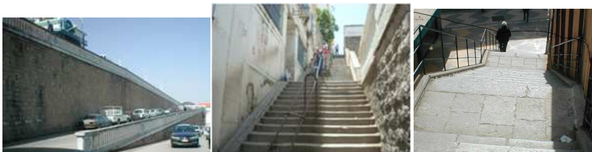
Figure n° 228 Mur de soutènement en pierre d'une hauteur considérable Source : auteur
