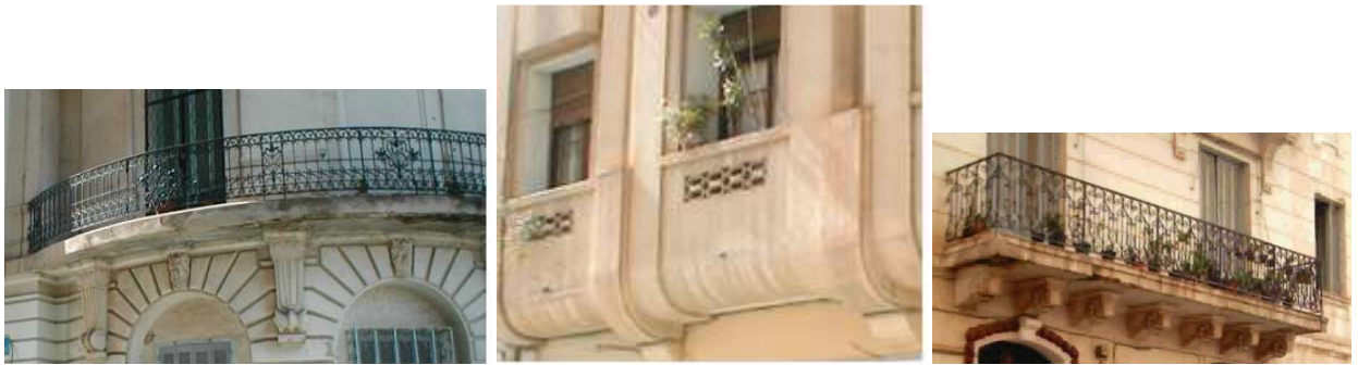
Figure n° 232 Des balcons et des éléments saillants variés qui enrichissent de plus en plus les façades. Source : auteur et DAU
