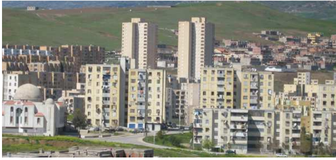
Figure n° 108 Vue d'ensemble. Source : Auteur et DAU
