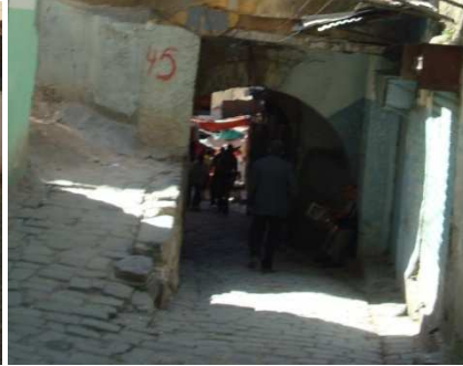
différenciation de niveau par un mur soutènement en pierre
