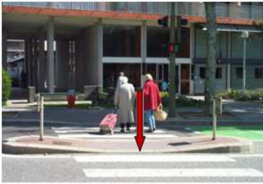
Figure n°68 Les abaissés des trottoirs facilitent le passage Source : Ville accessible à tous CERTU 2002
