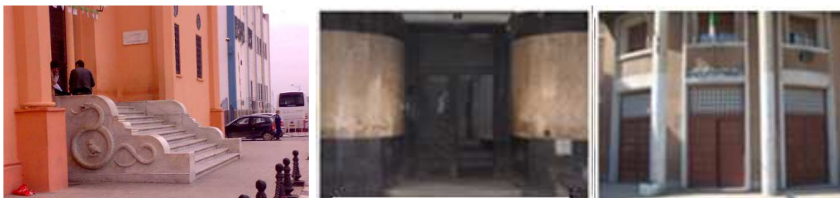
Figure n°229 Escaliers en marbre d'une pérennité séculaire.
