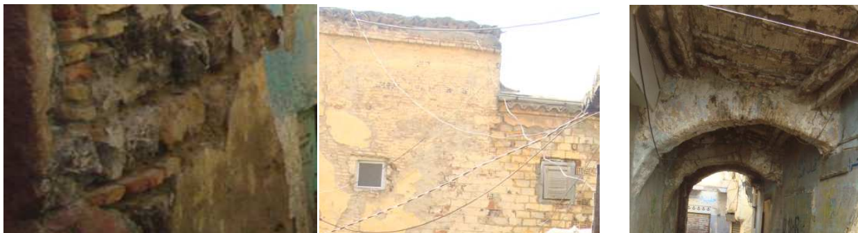
Mur de RDC en pierre intercalé de rangés de briques pleines
