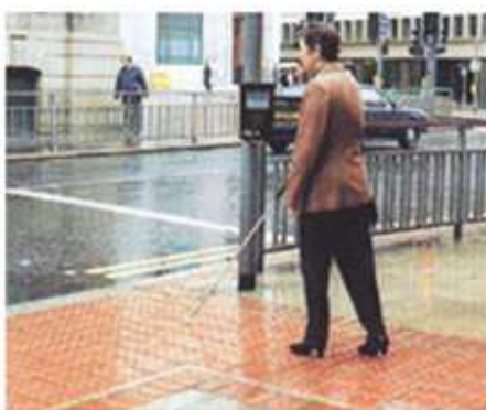
Figure n°39 Caractère donné au revêtement d'un trottoir pour orienter l'usager Source : conseil national des transports. 2005
