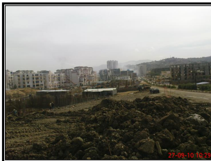
Figure 67: La collectivité agricole collective Kadour Belizidia qui s'est transformée en un chantier d'habitat collectif.
