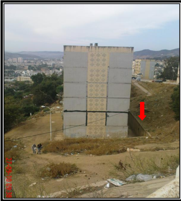
Figure 41 : Constructions soumises aux risques de glissement et d'instabilité du terrain.
