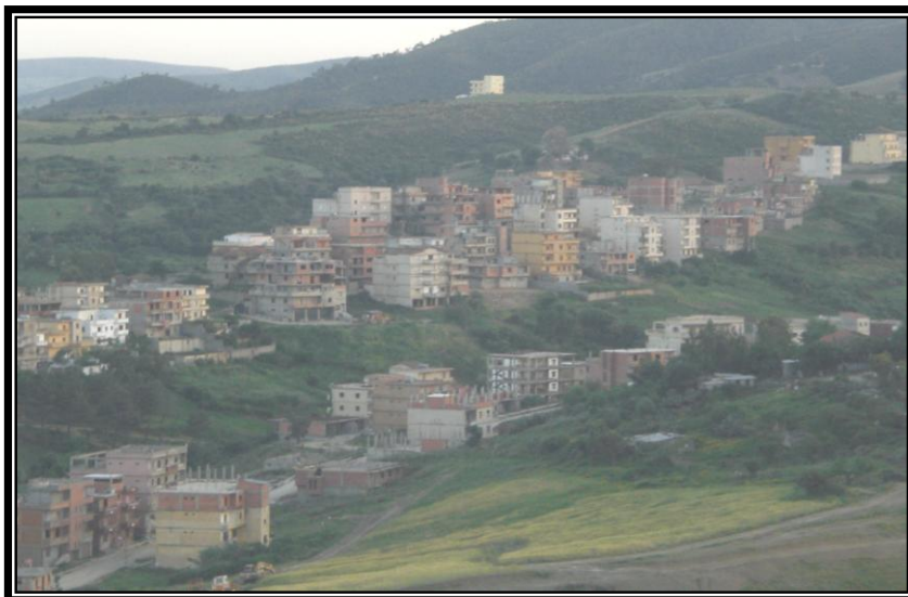
Figure 32 : Habitat individuel non achevé de plus en plus périphérique.
