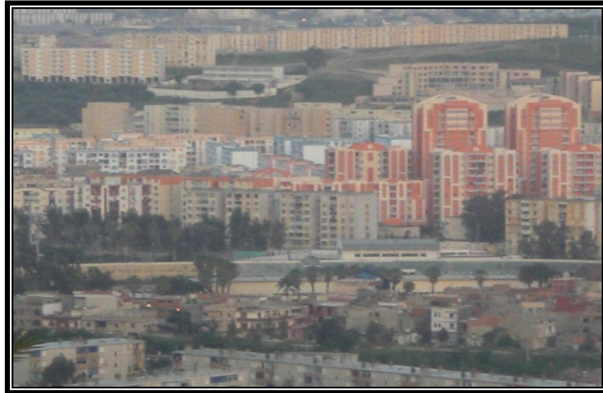
Figure 30 : Les grands ensemble à Skikda ; façade urbaine hétérogène et silhouette incohérente.
