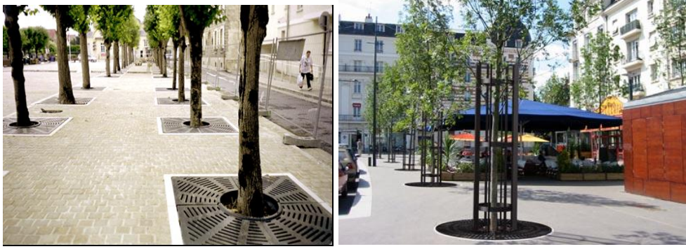
Figure 6: les protections d'arbres
