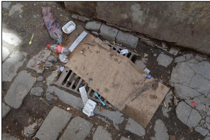
Figure 7.13 La mauvaise conduite des eaux extérieures à cause des avaloirs bouchés.
