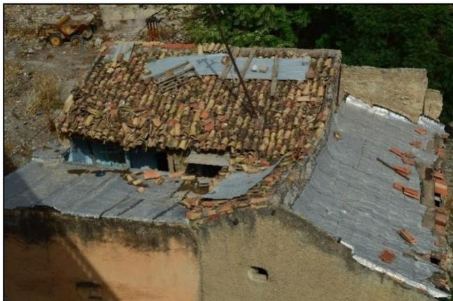
Figure 7.2 Toiture en tuile endommagée dans la Basse -Souika sous l'effet de la pluie
