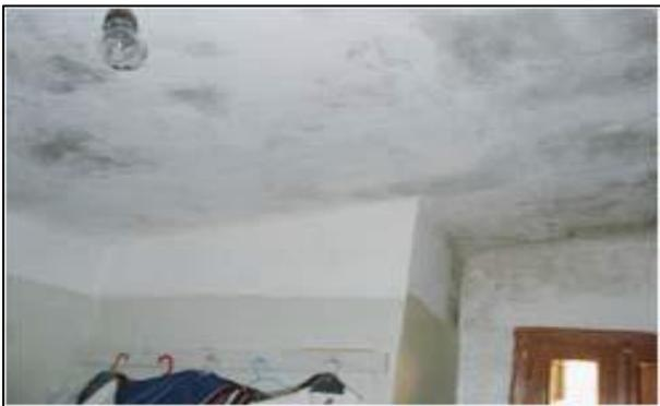
Figure 7.8 Mouillure des plafonds et l'apparition des taches blanches.
