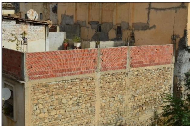
Figure 7.20 La superposition inadéquate de deux matériaux de construction différents.
