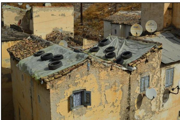
Figure 7.11 L'utilisation des couvertures en plastique à cause de la mauvaise étanchéité.
