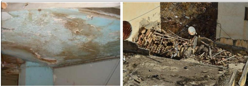
Figure 7.14 Les dégâts enregistrés dans les toitures à cause des pluies torrentielles.
