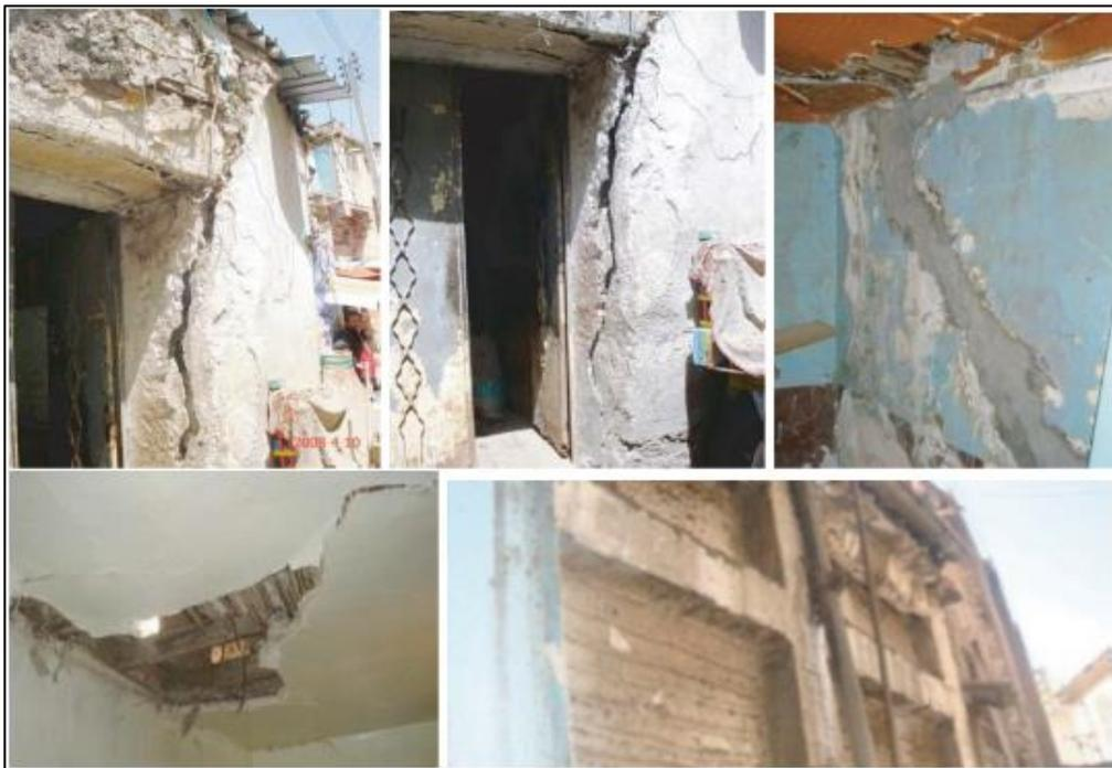
Figure 7.3 Aperçu sur quelques dégâts structuraux causés par les actions latérales.
