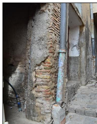
Figure 7.12 le mauvais raccordement des gouttières au niveau du quartier.
