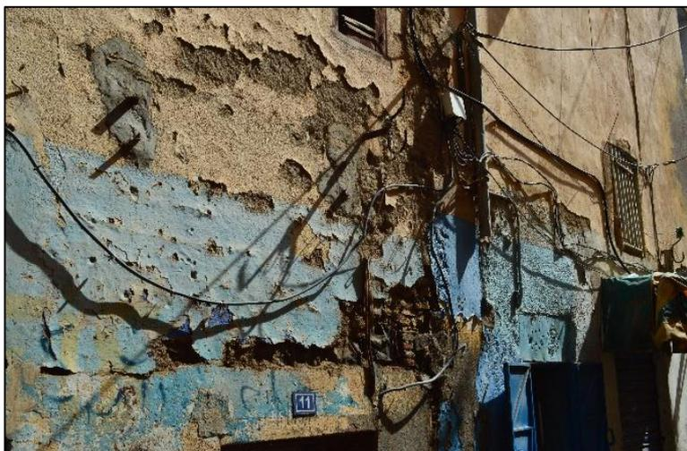
Figure 7.17 Le système électrique défectueux comme source d'incendie dans la « Souika ». Source : (Auteure, 2022).
