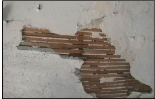
Figure 7.7 Dislocation profonde des murs à cause de l'humidité.
