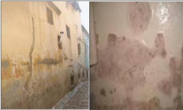
Figure 7.6 l'écaillage de la peinture extérieure et intérieure par l'humidité.
