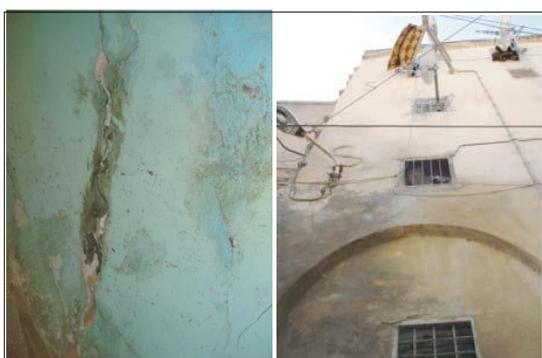
Figure 7.15 l'apparition des moisissures sur les murs intérieurs et extérieurs.
