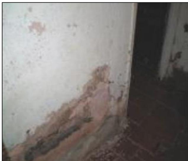
Figure 7.10 Ascension des eaux souterraines dans une cloison intérieure.
