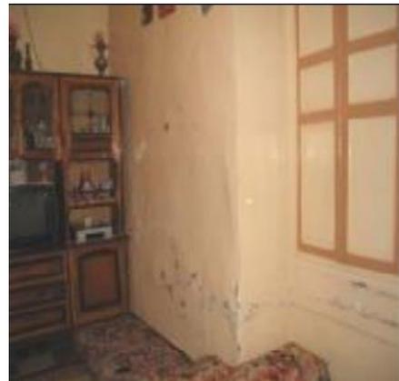
Figure 7.9 les remontées capillaires.
