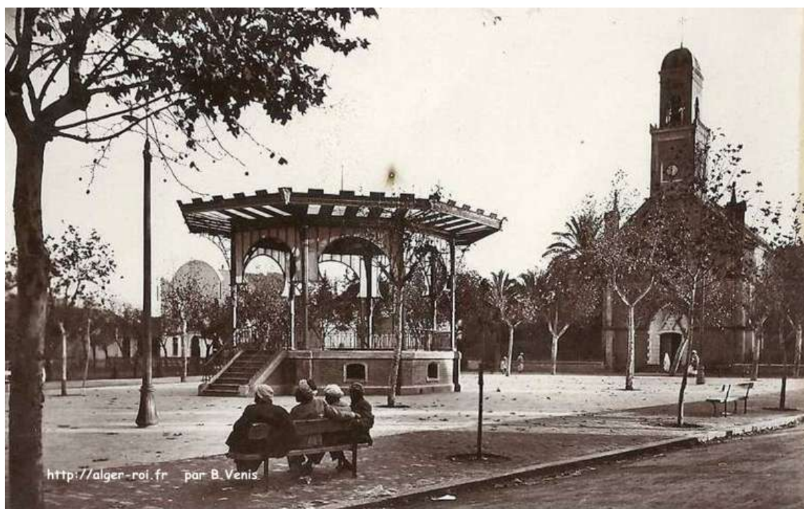
FIGURE III.12 – Ancienne photo de l'ex square d'El khroub ,Source : http://www.algeriemesracines.com
