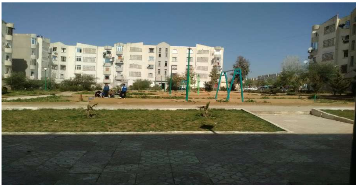
FIGURE VII.11 – les habitants ont aménagé un terrain de jeux pour leurs enfants au milieu des bâtiments des 1600 , Source, photo prise par l'auteur
