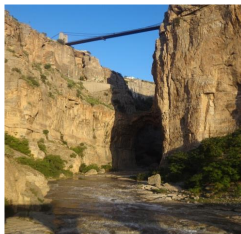
Figure 6.22 : La passerelle de sidi M'cid sur les gorges du Rhumel
