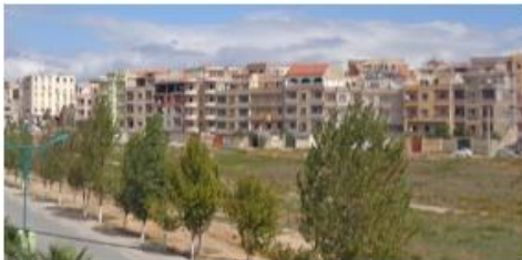
(Fig.4) : Vue sur la 2 ème séquence de l'entrée sud -côté Sonatiba-(Source : Auteur septembre 2015)
