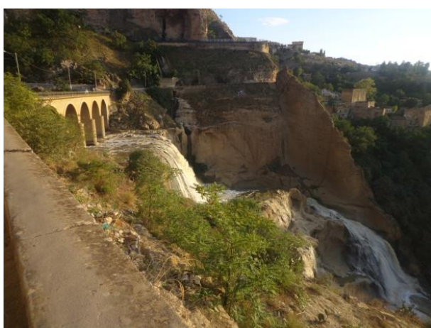
Figure 6.21 : Pont des chutes
