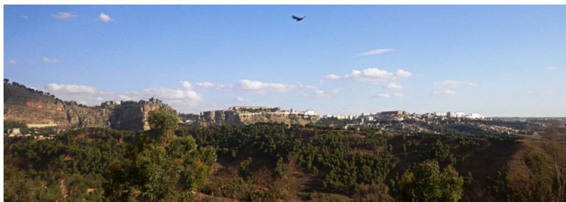
Figure 6.18 : Vue panoramique de Constantine. Vue prise à partir la route nationale n°3 - Sidi M'cid. (Section I du parcours de l'entrée)
