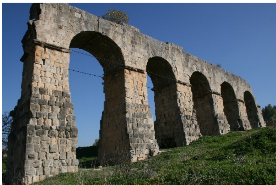
Figure 5-34: Vue sur les restes de l'aqueduc romain.
