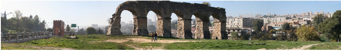
Figure 5-28: Photo sur les vestiges de l'ancien aqueduc romain.
