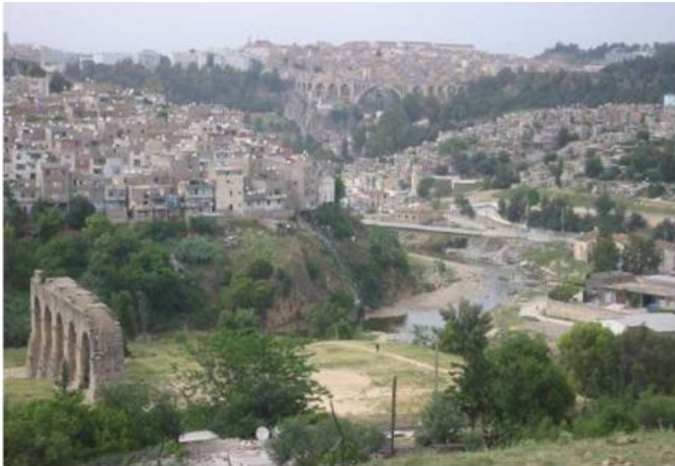
Figure 5-6 : Vue sur l'habitat spontané en dure et de l'aqueduc romain.
