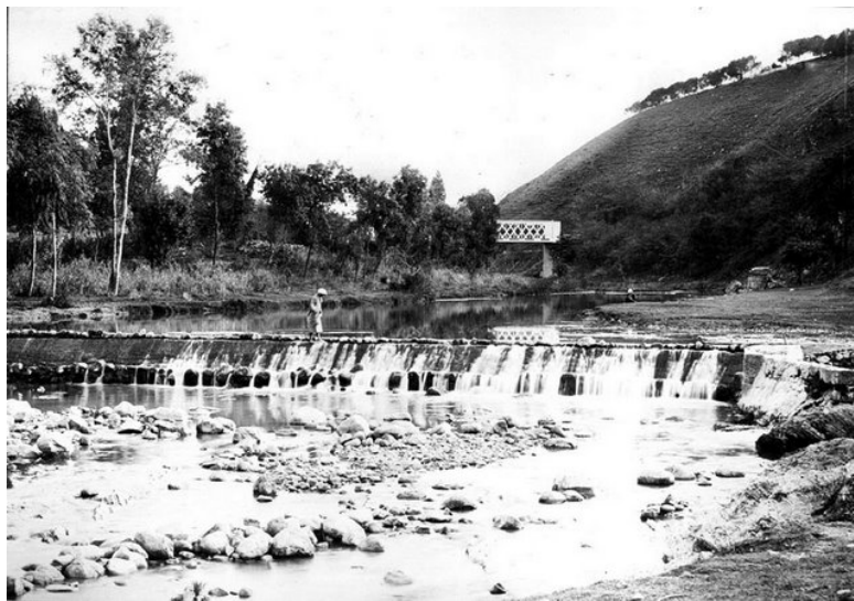
Figure 5-23 : Barrage Carbonel à bardo.
