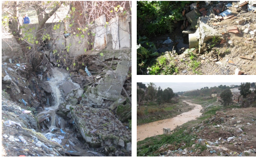
Figure 5-20: Déversement des eaux usées directement dans l'Oued.
