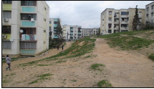
Figure 5.17 : Absence des tracés des voies de dessertes. Cité des 1039 logements. (Auteur, 2016)
