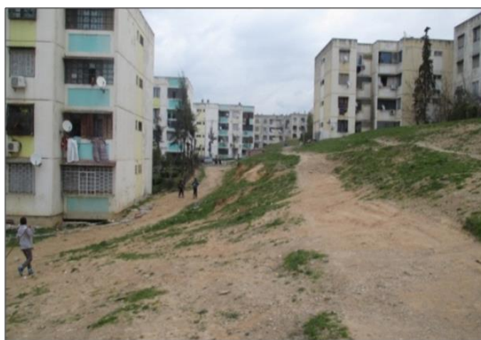
Figure 6.20 : Terrain en pente, en état brut cité 1039 des logements (Auteur, 2014)
