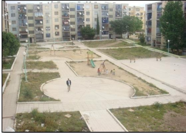
Figure 5.4: Aménagement d'une cour urbaine. Cité des 1600 logements (Auteur, 2011)
