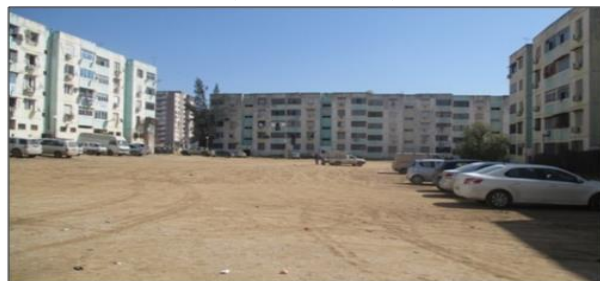
Figure 6.18 : Espace no man's lands (cours urbaine) au sein de la cité des 1013logements (lot N° 17) (Auteur, 2016).
