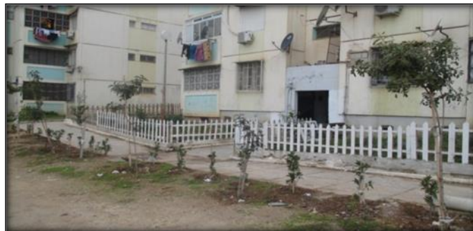
Figure 6.24: Pied d'immeuble. Cité des 1200 logements. (Auteur, 2014)
