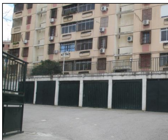
Figure 8.10 : Locaux commerciaux transformés à des garages pour les habitants. (Auteur, 2016)
