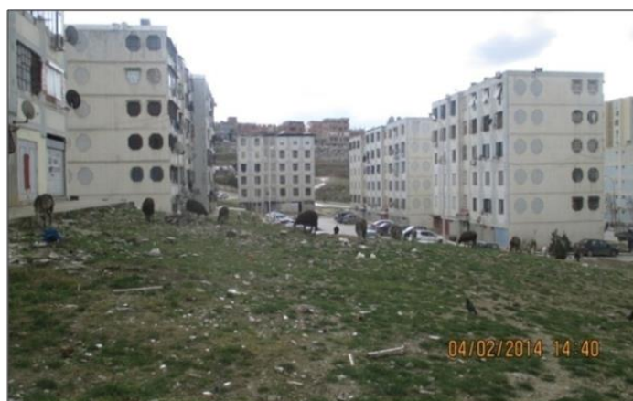
Figure 6.19 : Cité des 900 logements ; espace no man's land où s'entremêlent pratiques urbaines et autres rurales (Auteur, 2014)
