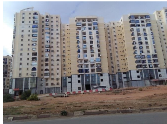
Figure 6.22 : Façade de la cellule F3 du type AADL des Blocs B1/B7/D1/D2.
