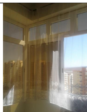
Figure 7.35 : La fermeture du séchoir par une véranda. Source : Auteur, 2018
