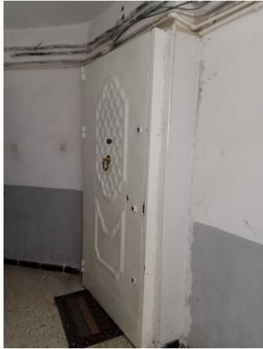
Figure 8.4 : Placé d'une porte métallique pour la sécurité. Source : Auteurs, 2018
