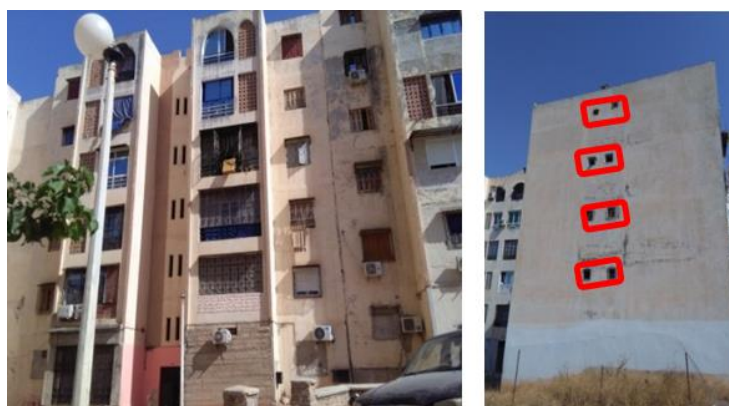
Figure 8.1: Création des ouvertures des sanitaires sur le mur aveugle. Source : Auteur, 2018
