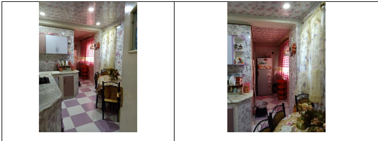
Figure 7.20: Suppression du mur qui sépare la cuisine au séchoir pour agrandir la taille de cuisine. (Transformation lourdes), l'utilisation de PVC au plafond, du failliance, et la dalle de sol, changer l'emplacement du plan de travail (transformation légère). Source : Auteur, 2018
