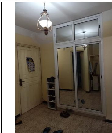
Figure 7.27 : La création d'un placard mural dans le hall. Source : Auteur, 2018
