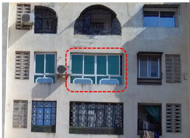
Figure 8.3 : Agrandissement du séjour avec la suppression de la paroi qui sépare le séjour/ balcon et ont utilisant des vérandas dans les balcons pour la fermeture. Source : Auteurs, 2018
