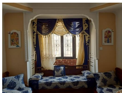
Figure 7.19: Suppression du mur qui sépare la chambre d'enfant au balcon, la création d'un placard mural. Transformation lourdes. Source : Auteur, 2018
