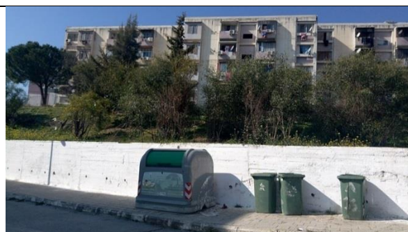
Figure 5.18 : Bornes aériennes posées à la cité Ziadia.
