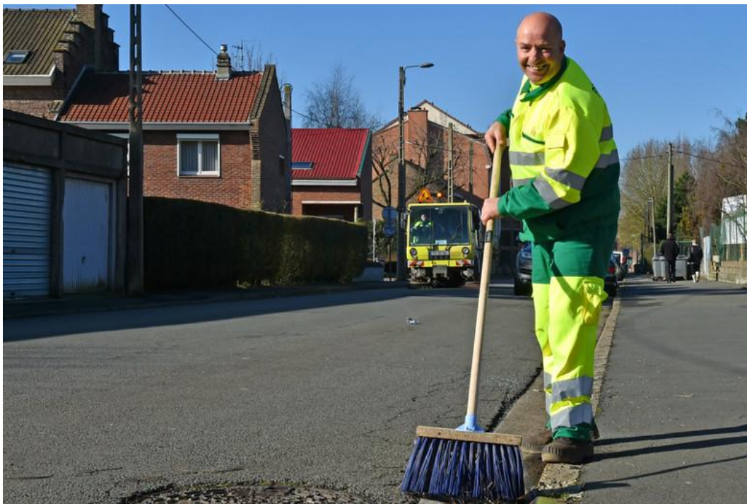
Figure 4.1: Utilisation du balai pour assurer le nettoyage du caniveau.
