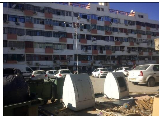
Figure 5.16: Bornes enterrées posées à la cité Filali Source : Auteur, Février 2020
