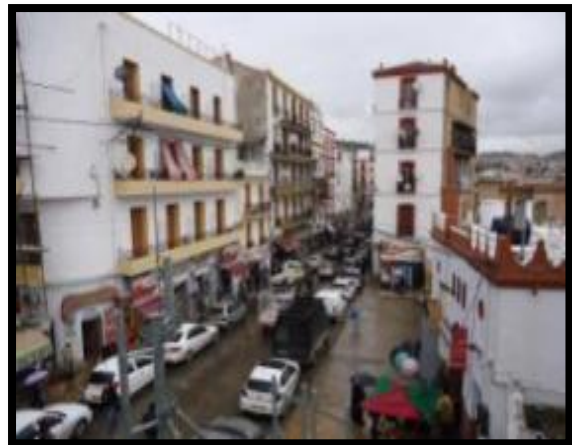
Figure N° 6.2 : vue de façade principale Rue Larbi Ben M'hidi, source: auteur (2018) .
