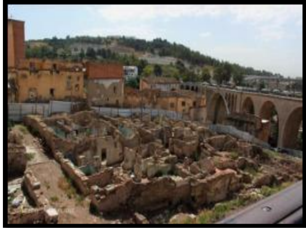
Figure 5.16: état du patrimoine 2019
