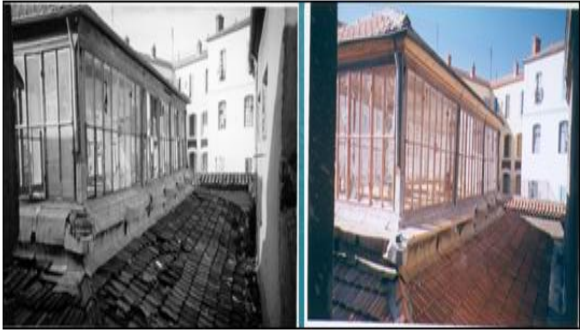
Figure N° 7.5: travaux de toiture en 2003, Source : DLEP 2003.
