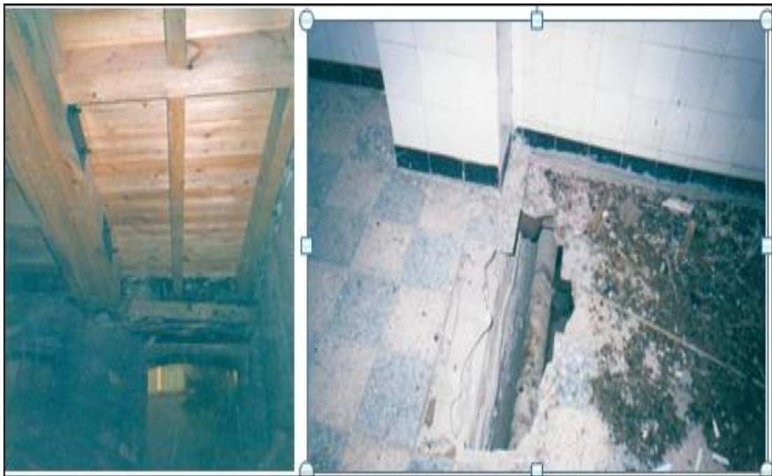
Figure N° 7.6 : Reprise des planché, Source : DLEP 2003
