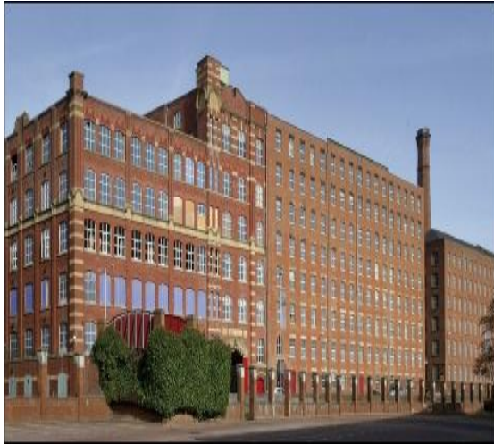
Figure N°2.3: Royal mill, l'une des plus grandes filatures de coton de Manchester a fait l'objet d'une reconversion multifonctionnelle privée. Elle accueille depuis 2003 des logements, bureaux et commerces. Source: Real E (2015) Reconversions
