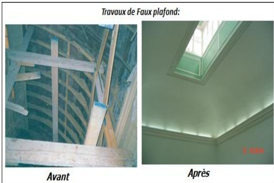
Figure N° 7.9: travaux de faux plafond, source: DLEP 2003.
