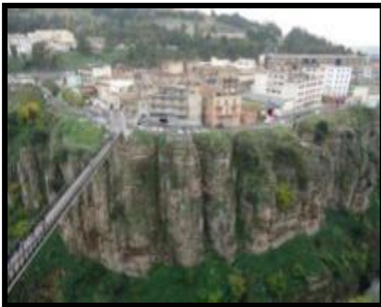
Figure N° 6.1: vue de façade Est passerelle Mellah Sliman. source: Auteur.
