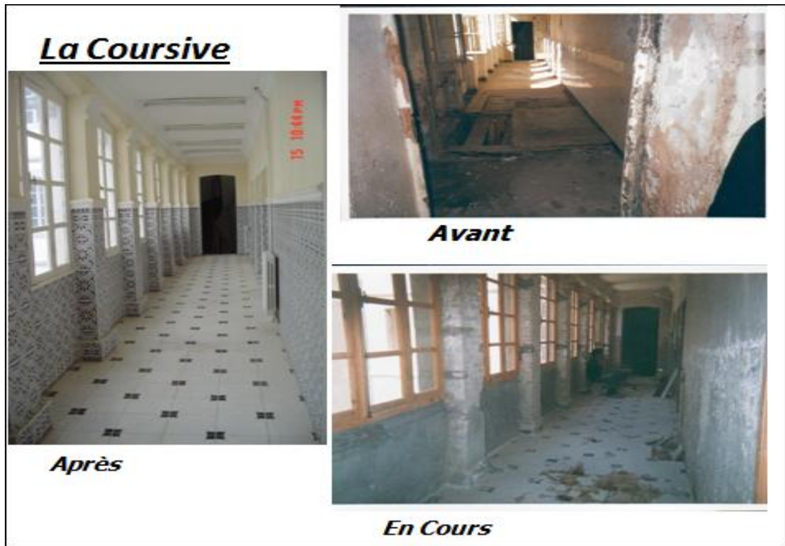
Figure N° 7.7: avant et après les travaux, Source: DLEP 2003.
