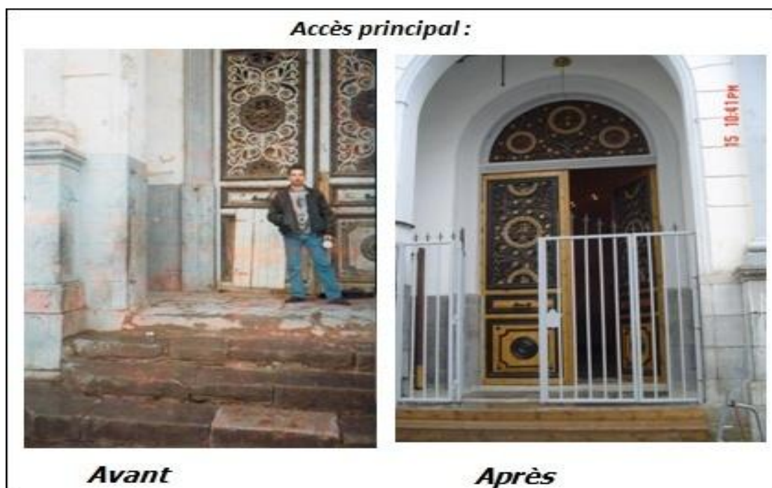
Figure N° 7.10: entrée principale avant et après les travaux. Source :DLEP (M me Hanach 2013)
