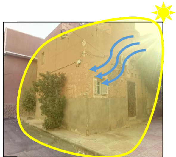
Figure 4. 14 : Logement Siddi Abbaz intégré dans le contexte du site Siddi Abbaz. Source : Auteur, 2020.
