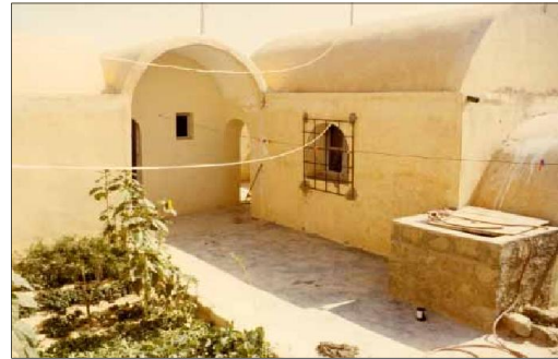
Figure 1. 22 : Les logements du village de Madher en construction, avec leurs voûtes appropriées pour les toits ; Vue d'une cour.
