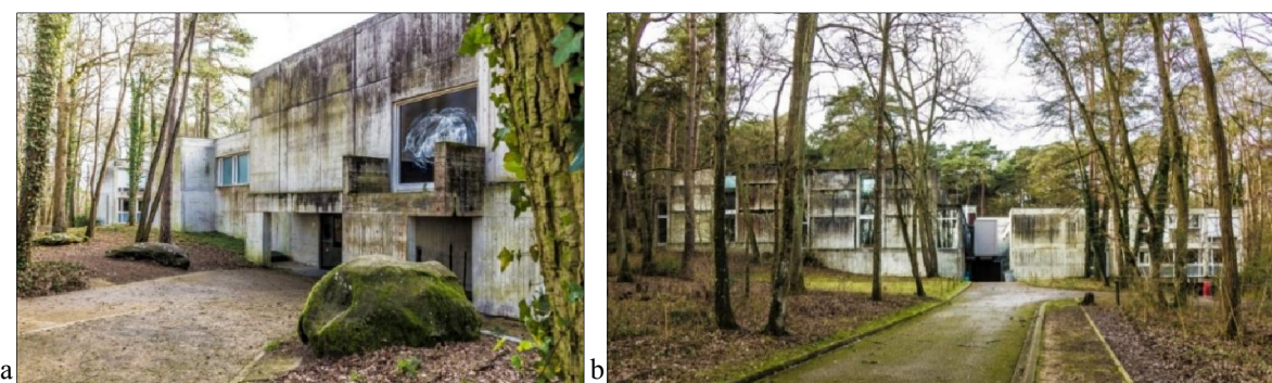
Figure 1. 12 : a-Plan masse du projet Djenan el-Hasan ; b- Vue d’ensemble de la cité de Djenan El-Hasan, inséré dans le paysage de Frais Vallon.
