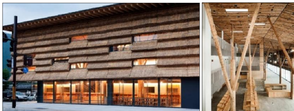
Figure 2. 17 : La façade principale et la structure interne de l'hôtel Yusuhara Marche.
