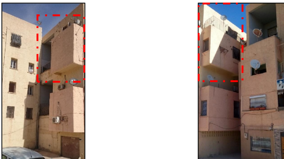
Figure 4. 4 : Les façades du logement duplex sélectionné.
