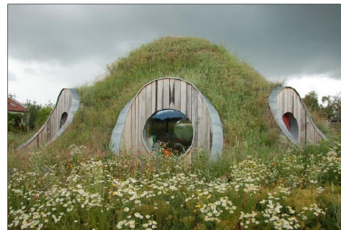
Figure 2. 22 : Maison expérimentale à Hrubý Šúr (Senec, Slovaquie), d'un toit jardin voûté et couvert par des balles de paille.
