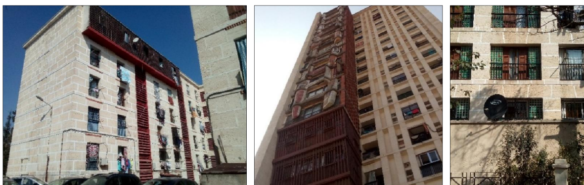
Figure 1. 14 : Logements Diar-es-Saada : Eléments architectoniques traditionnels dans des façades modernes. Source : Auteur, 2020.
